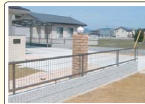
○ブロック フェンス○
