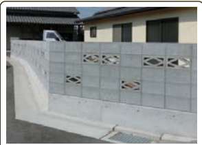
○ブロック工事○
